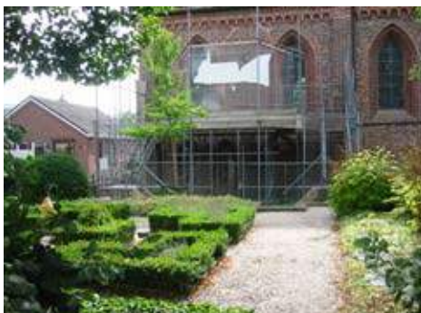
8. Installatie Abdijkerk, Abdijsstraat
