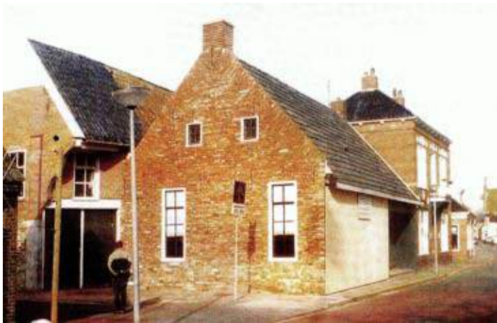
St. Zuiderpoort Klooster Aduard
